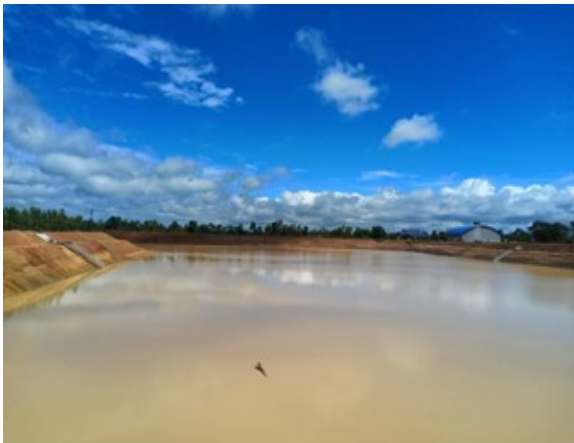
ขุดลอกหนองขำน้อย พื้นที่ ๖๖ ไร่ ดำเนินการเสร็จเรียบร้อยแล้ว
